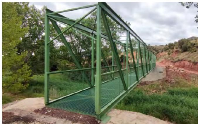
Figura 4. Reconstrucción del puente del ferrocarril minero para habilitarlo como parte de la vía verde.
