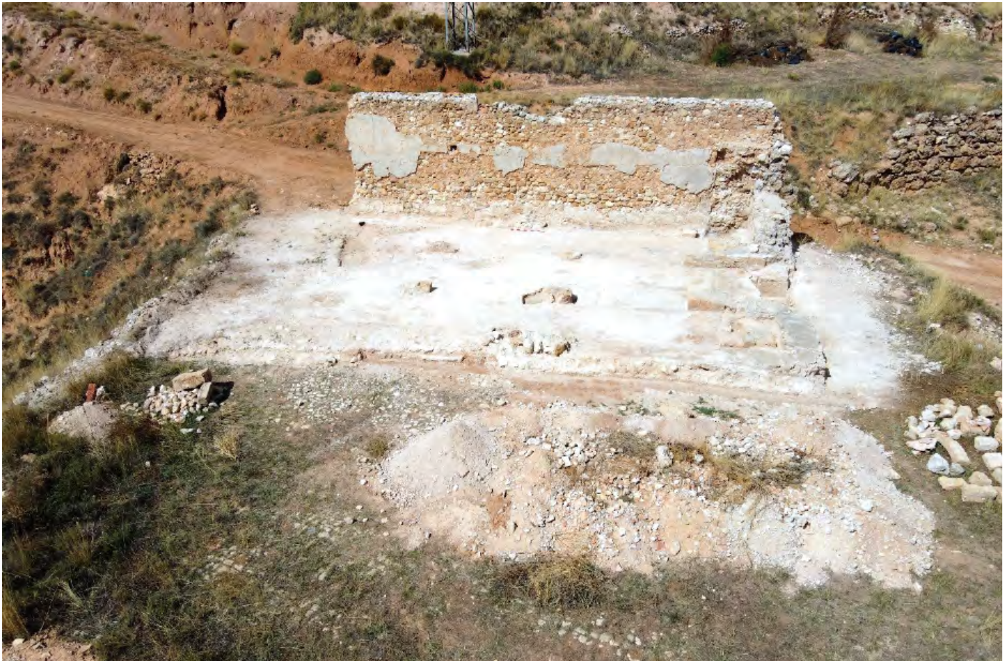
Fig. 2º: Vista aérea del edificio desde el sur.
